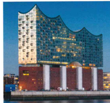
63.000 Kubikmeter Beton lieferte Holcim für die Elbphilharmonie.
